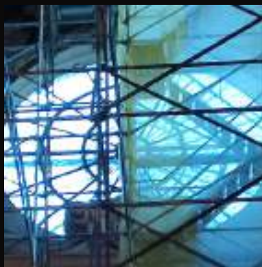
idriera en construcción
