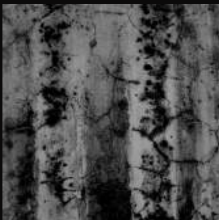
Grietas del dosel de las sombras
