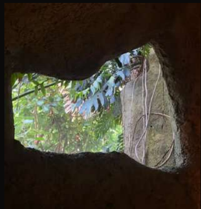
Ventana arrancada en la piedra
